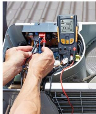
Spannungsmessung an einer Kälte-Außeneinheit mit **testo 760-3**.
