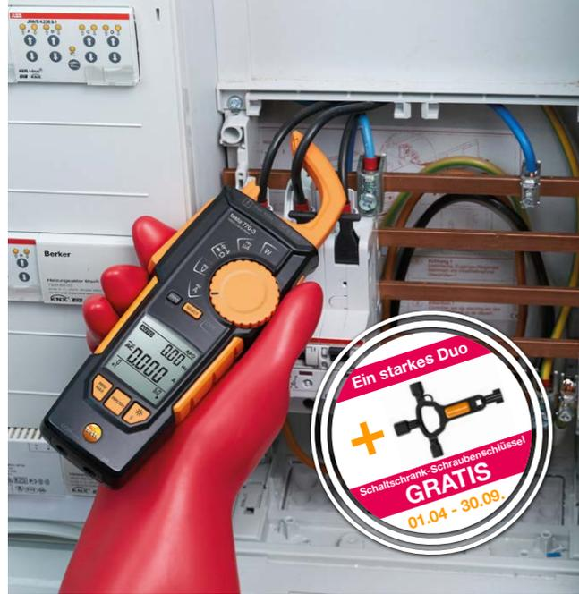
Strommessung an einem Klimagerät mit **testo 770-3**.
